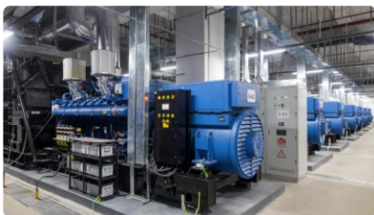
东方国信工业互联网北方区域中心 42*2000kW
