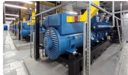
世纪互联乌兰察布云数据中心 51*2000kW
