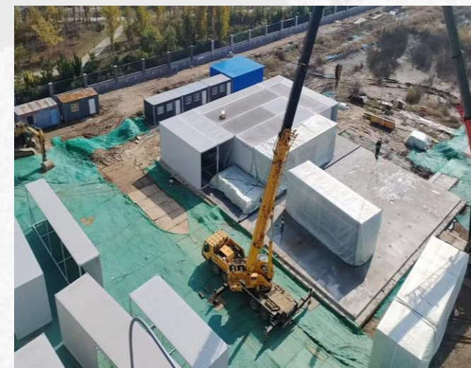
现场专业吊装
