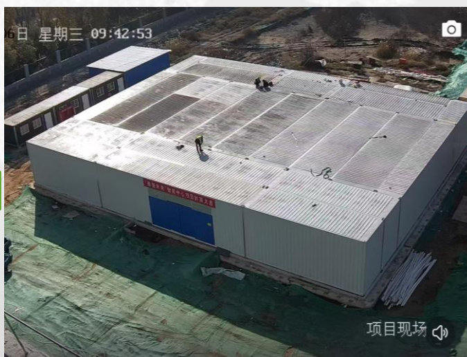
并箱、防水、内部管线连接
