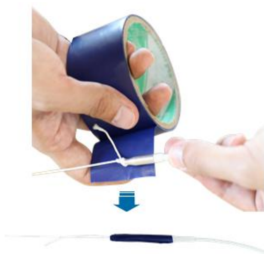
图B. 5 连接处固定示意图
