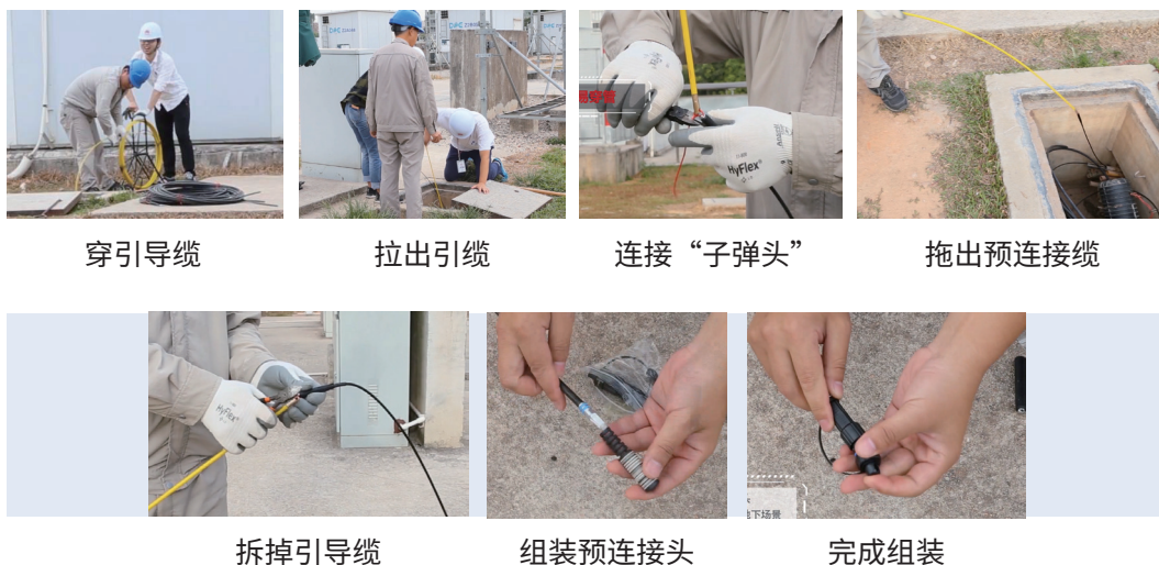
❗ 图 5-13 室外管道应用场景穿管施工过程 ❗
