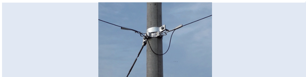
❗ 图 5-12 架空光缆跨电杆安装 ❗
