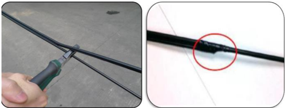
图B. 2-2 剪去光缆加强件
