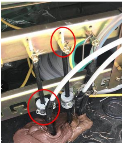
图B. 3-1 光缆在交接箱的固定
