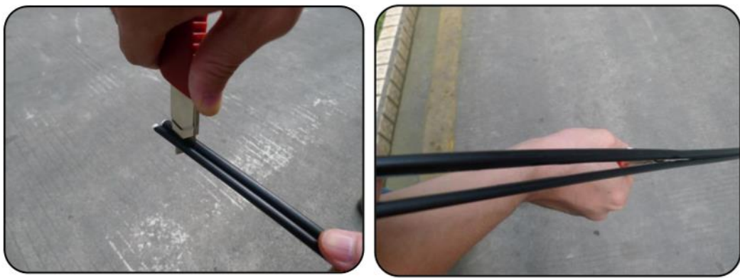
图B. 2-1 将光缆加强件与光缆分割开
