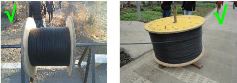
图B. 1-2 光缆用放线架放线
