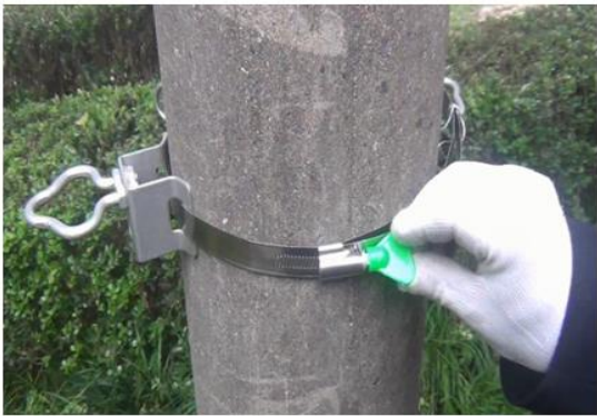
图B. 1-1 在电杆上安装钢带式抱箍
